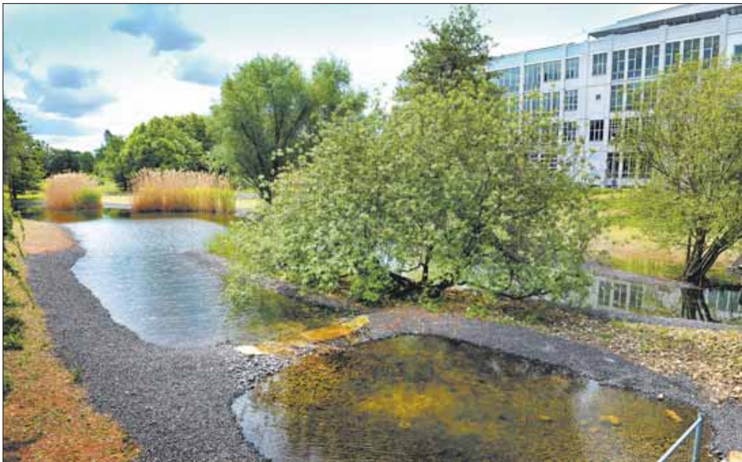
Rund 25 Jahre lang dümpelte der kleine See vor dem Technoseum vor sich hin. Von Pflanzen überwuchert, gab die Technik im künstlich angelegten Gewässer so langsam ihren Geist auf, der Wasserverbrauch stieg stetig. Es war also höchste Zeit, etwas zu tun. Foto: Gerold
